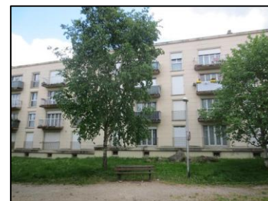
Photo N° 33 ECH-N°23 -1R+3 - Esc8-9 Ribot Façades Murs Enduit + peinture
