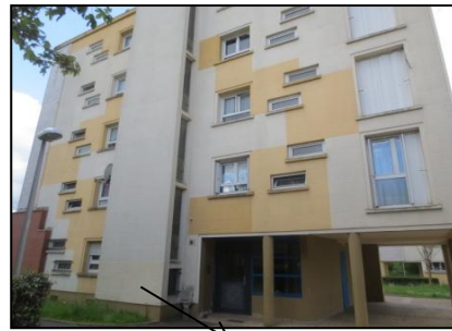
ECH-N°41 -1R+4-Esc. 10 J.SIEG.- Façades/Murs Mortier + peinture, (photo n° 72)
