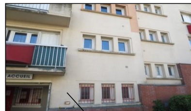
ECH-N°2 -1R+8-BAT.13 - Façade/Murs Mortier + peinture, (photo n° 3)
