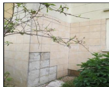
Photo N° 53 ECH-N°29 -1R+4 - Esc.2-3J.SIEG. Façades Murs Colle faïence
