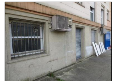
Photo N° 20 ECH-N°12 -1R+4 - Esc.1-2 Ribot Façades Soubassement - Murs Mortier + peinture
