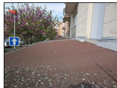
Photo N° 78 ECH-N°14 -1R+4 - Esc.1-2 Toits commerces Toiture Shingle
