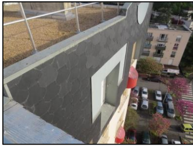
Photo N° 102 ECH-N°42 -1R+8 - BAT.13 Façade haute Ardoises Ardoises
