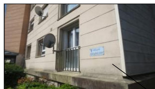
ECH-N°17 -1R+3-Esc.4à7 Ribot-Façades/Sousbassement - Murs Enduit + peinture, (photo n° 81)
