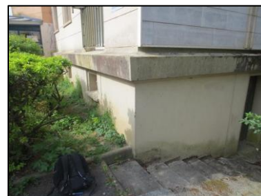
Photo N° 81 ECH-N°17 -1R+3 - Esc.4à7 Ribot Façades Soubassement - Murs Enduit + peinture
