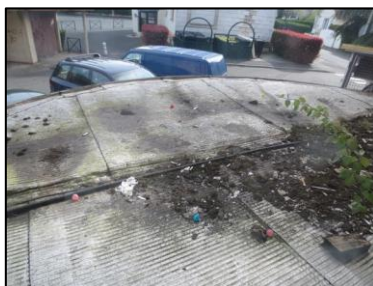
Photo N° 77 ECH-N°11 -1R+4 - 1-2 Ribot Casquettes Halls Etanchéité Toiture Pax alu
