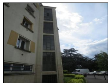
Photo N° 91 ECH-N°35 -1R+4-Esc5-6J.SIEG. Baie vitrée escalier Baies vitrées Mastic
