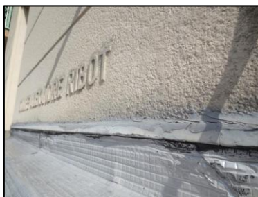
Photo N° 80 ECH-N°16 -1R+4 - Esc.1-2 Toits commerces Etanchéité - Bavette Mastic
