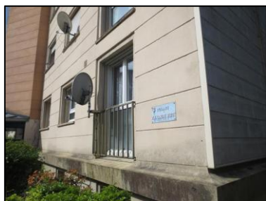
Photo N° 82 ECH-N°18 -1R+3 - Esc.4à7 Ribot Façades Murs Enduit + peinture
