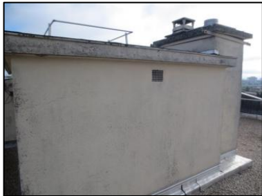
Photo N° 107 AMIANTE CIMENT -1R+8 - BAT.13 Toiture Conduits de ventilation Ventilation haute (Fibres-ciment)
