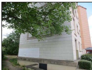
Photo N° 32 ECH-N°21 -1R+3 - Esc8-9 Ribot Pignons Etanchéité - Plaques Polystyrène + colle + plaque
