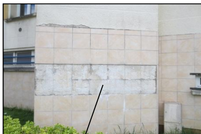
ECH-N°33 -1R+4-Esc.5-6J.SIEG.-Façades/Murs Colle faïence , (photo n° 90)
