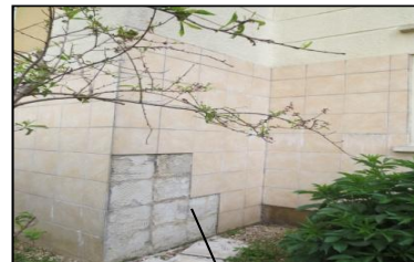
ECH-N°29/2/3 J. SIEG.--1R+4-Esc.2-3J.SIEG.-Façades/Murs Colle faïence , (photo n° 53)
