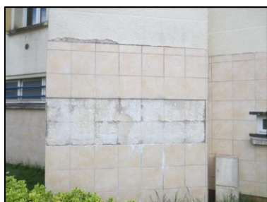
Photo N° 90 ECH-N°33 -1R+4 - Esc.5-6J.SIEG. Façades Murs Colle faïence
