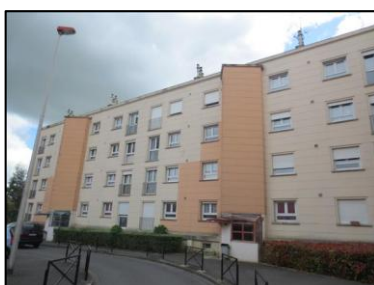
Photo N° 40 ECH-N°27 -1R+3 - Esc11-12 Ribot Baie vitrée escalier Baies vitrées Mastic
